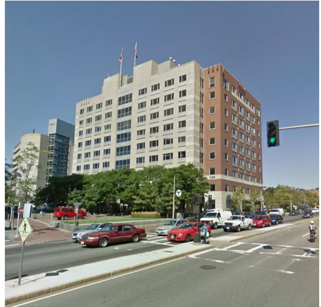
NU RENAISSANCE BLDG.
