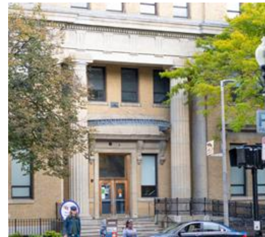
Centro comunitario en Roslindale
