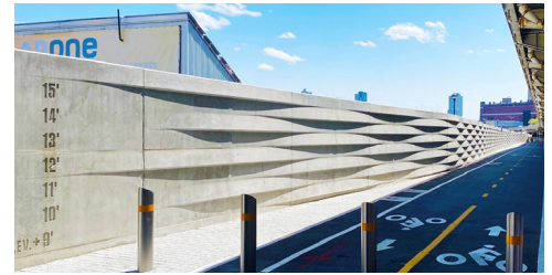
Muro de contención con acabado de concreto arquitectónico en el proyecto de resiliencia costera en el lado este en Nueva York (Fuente: OFTN Architecture)
