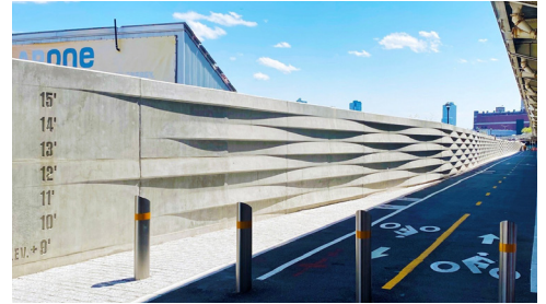
纽约市 East Side海岸抗洪项目的建筑混凝土饰面防洪墙 (来源:OFTN Architecture)
