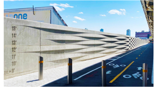
紐約市的東岸海岸防洪專案中，防洪牆經建築級混凝土外觀處理 (資料來源：OFTN Architecture)
