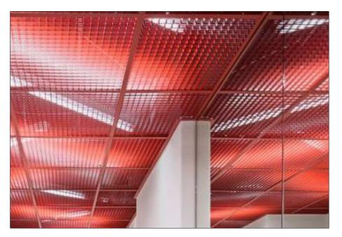
LINEAR DIRECT/INDIRECT ABOVE PERFORATED METAL CEILING
