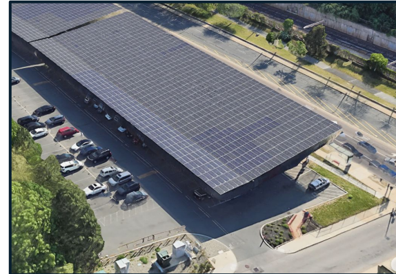
~1 MW Solar Canopy - Roxbury, MA
