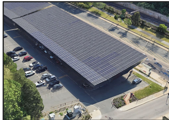
~1 MW Solar Canopy - Roxbury, MA
