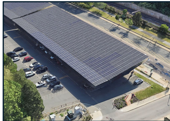
~1 MW Solar Canopy - Roxbury, MA
