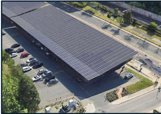
~1 MW Solar Canopy - Roxbury, MA
